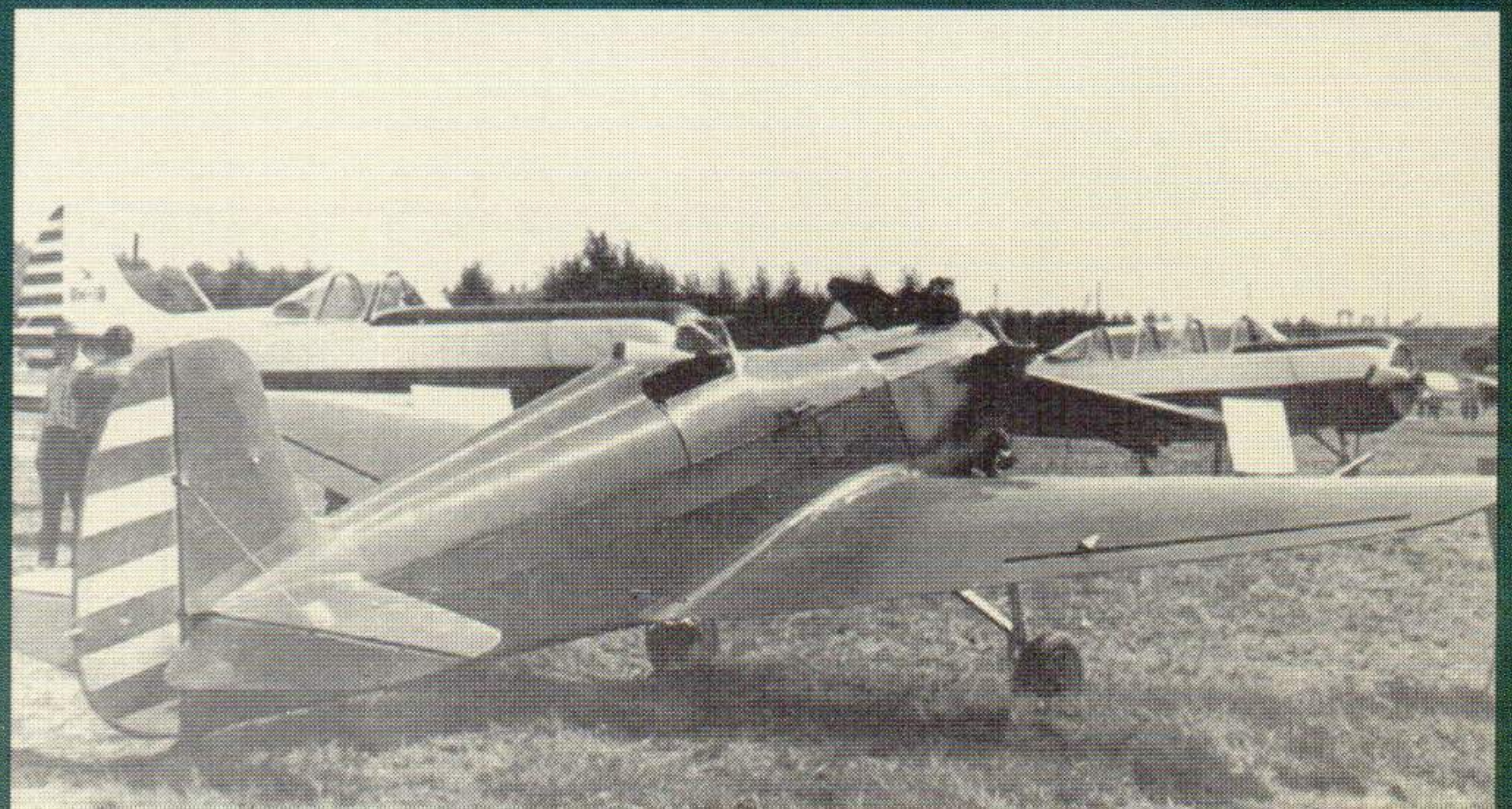
Самолет УТ-1 №0/02 выпуска 1940 года. Киль увеличенной площади был впоследствии переделан до стандартных размеров. Снимок сделан в 1967 году. Сейчас этот самолет находится в музее ОКБ А.С.Яковлева
